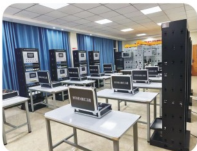
综合布线实训室
